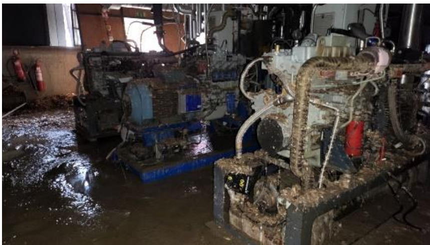
Slika 34: Stanje naprav za kogeneracijo po poplavih avgusta 2023 59
