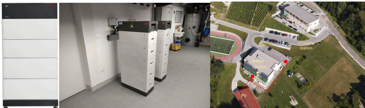
Slika 18: Li-ionska baterija LiFePO 4 z LFP tehnologijo in zmogljivostjo 24 kWh 40
