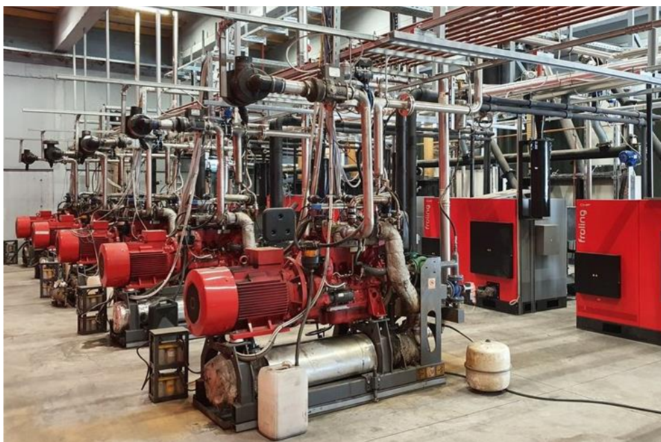
Slika 33: Naprave za kogeneracijo v biomasnem centru Nazarje 57
